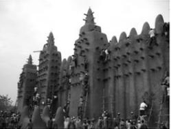
Debido a que este templo (ubicado en la ciudad de Djenné en Mali) está construido con barro, sus muros se erosionan naturalmente y se tienen que resanar cada año. Este proceso de conservación se logra principalmente a través de una gran fiesta anual en la que las personas de los
